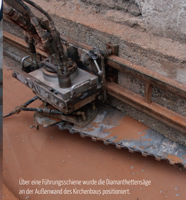
Keilplatten aus Kunststoff werden in die Sägefuge eingeschlagen, um eine Setzung zu verhindern und die Tragfähigkeit nicht zu beeinträchtigen.
