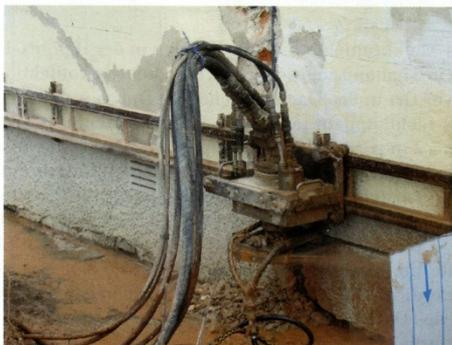
Über eine Führungsschiene wurde die Diamantkettensäge an der Außenwand des Kirchenbaus positioniert. Die Säge schneidet abschnittsweise eine Fuge durch das Gestein, in die anschließend eine Edelstahlplatte eingezogen wird. Auf diese Weise wird die Mauer vollständig abgedichtet, sodass keine kapillare Feuchtigkeit mehr hochsteigen kann.
