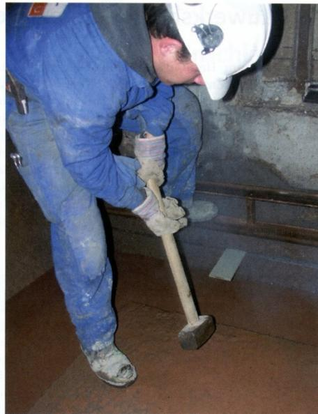
Um eine Setzung zu verhindern und die Tragfähigkeit nicht zu beeinträchtigen, wurden nach Einbau der Isolation in regelmäßigen Abständen Keilplatten aus Kunststoff in die Sägefuge eingeschlagen. Danach wurde der Sägeschnitt mit sulfatbeständigem Quellschlamm verpresst und verputzt. Fotos: Jörg GmbH
