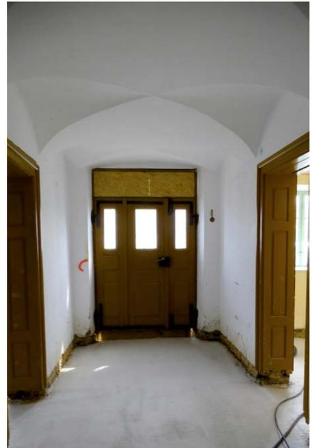
(3) Nach Einbringen der nachträglichen Abdichtung konnte das Erdgeschoss mit den Kreuzgewölben von Grund auf saniert werden.
